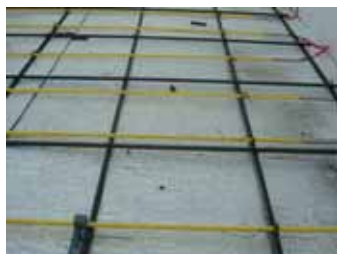
HMシート敷込中の写真です。
