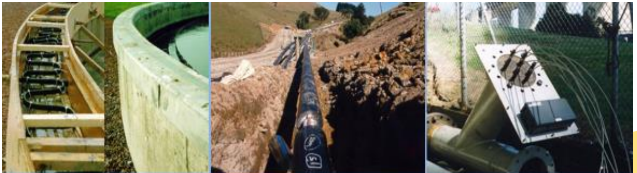
タンク壁の凍結防止
